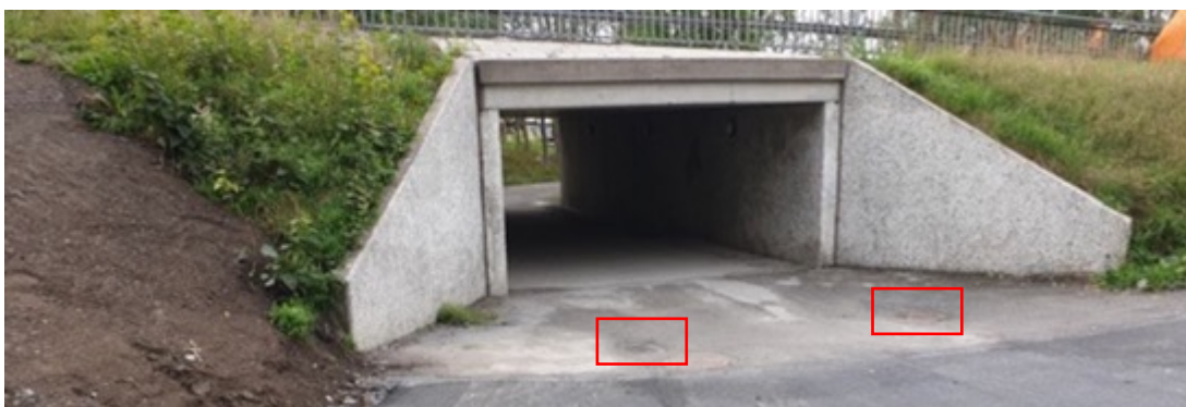
Figur 3. Två dagvattenbrunnar (röda rektanglar) vid gång- och cykeltunneln i nordöstra delen av planområdet Amperen. Foto: Geoveta.
