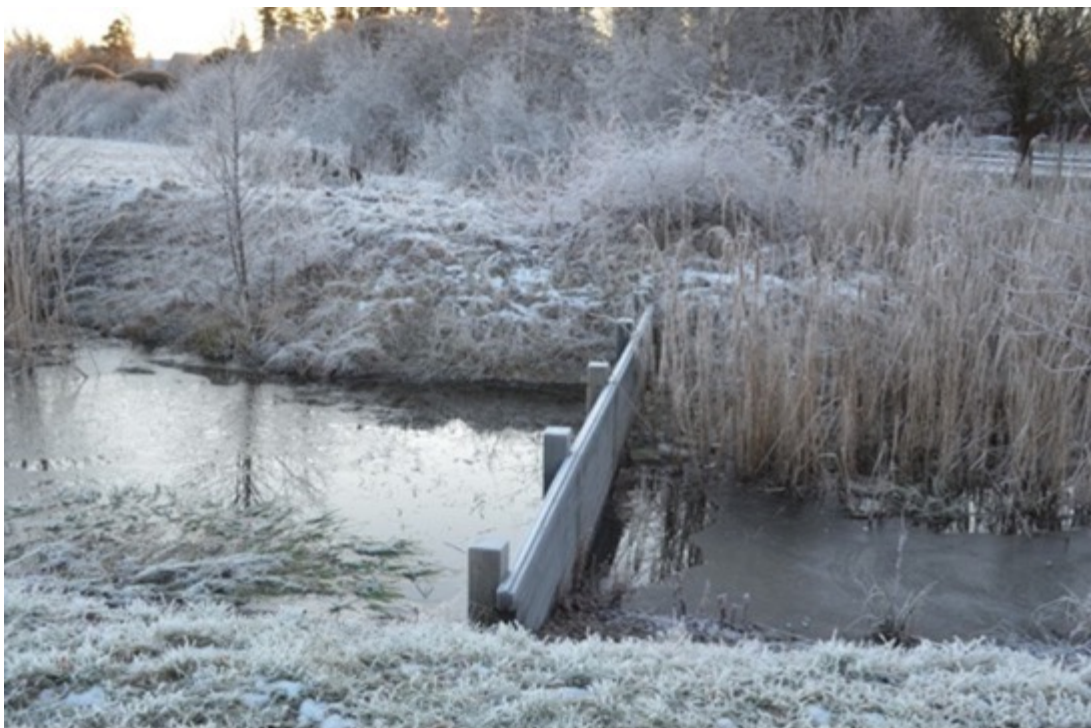
Figur 19. En träskärm avslutar fördammen och fungerar på så sätt som en olje- och skräpavskiljare. Vatten tillåts passera under skärmen och flytande orenligheter blir kvar i fördammen. Foto: Geoveta
