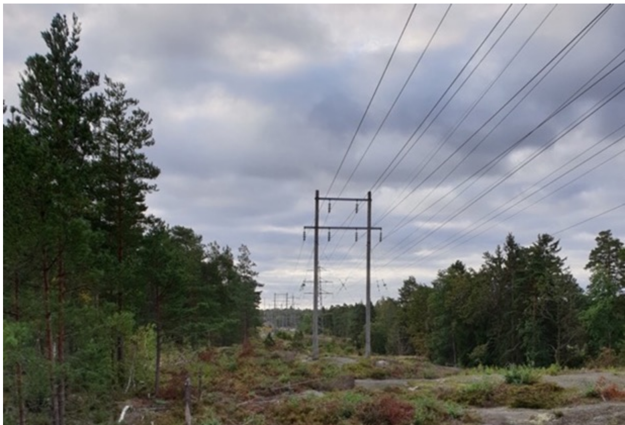
Kraftledningsstråket i Orminge i planområdet Amperen september 2019.
