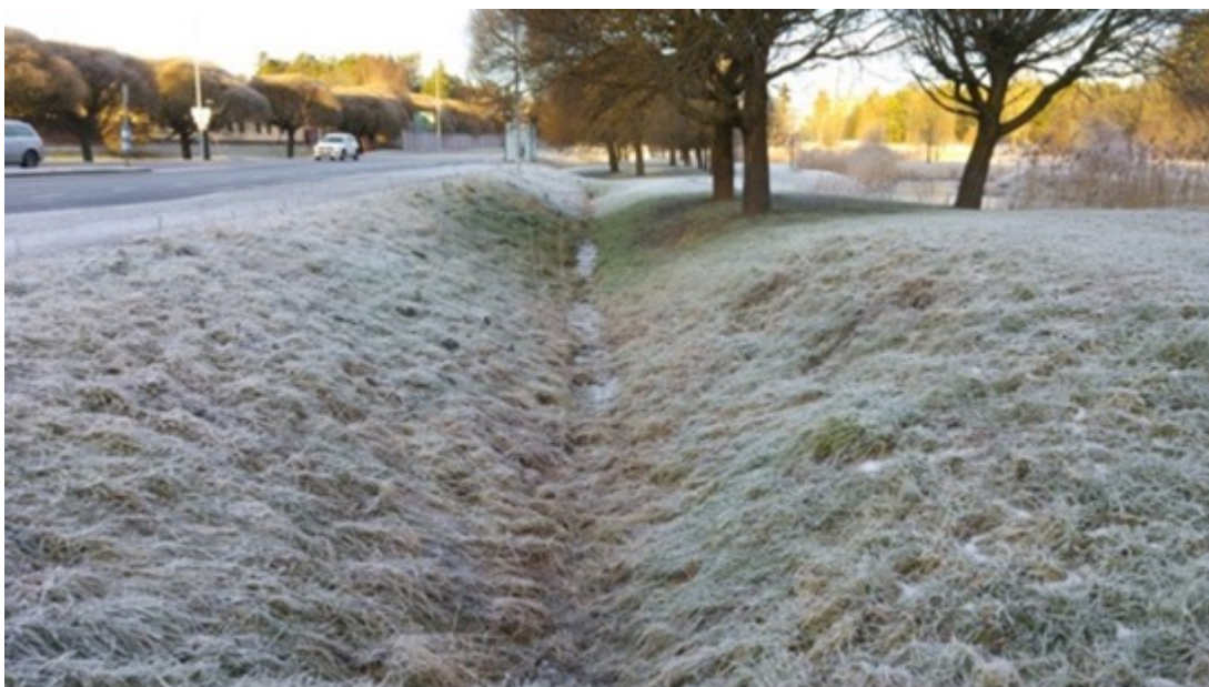
Figur 12. Exempel på svackdike. Foto: Geoveta
